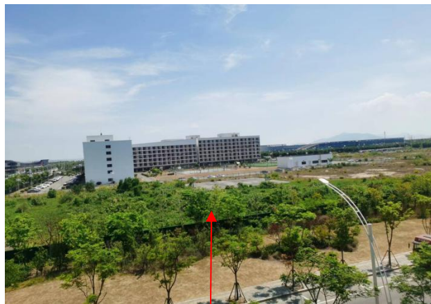
东北侧威马汽车制造温州有限公司职工宿舍
