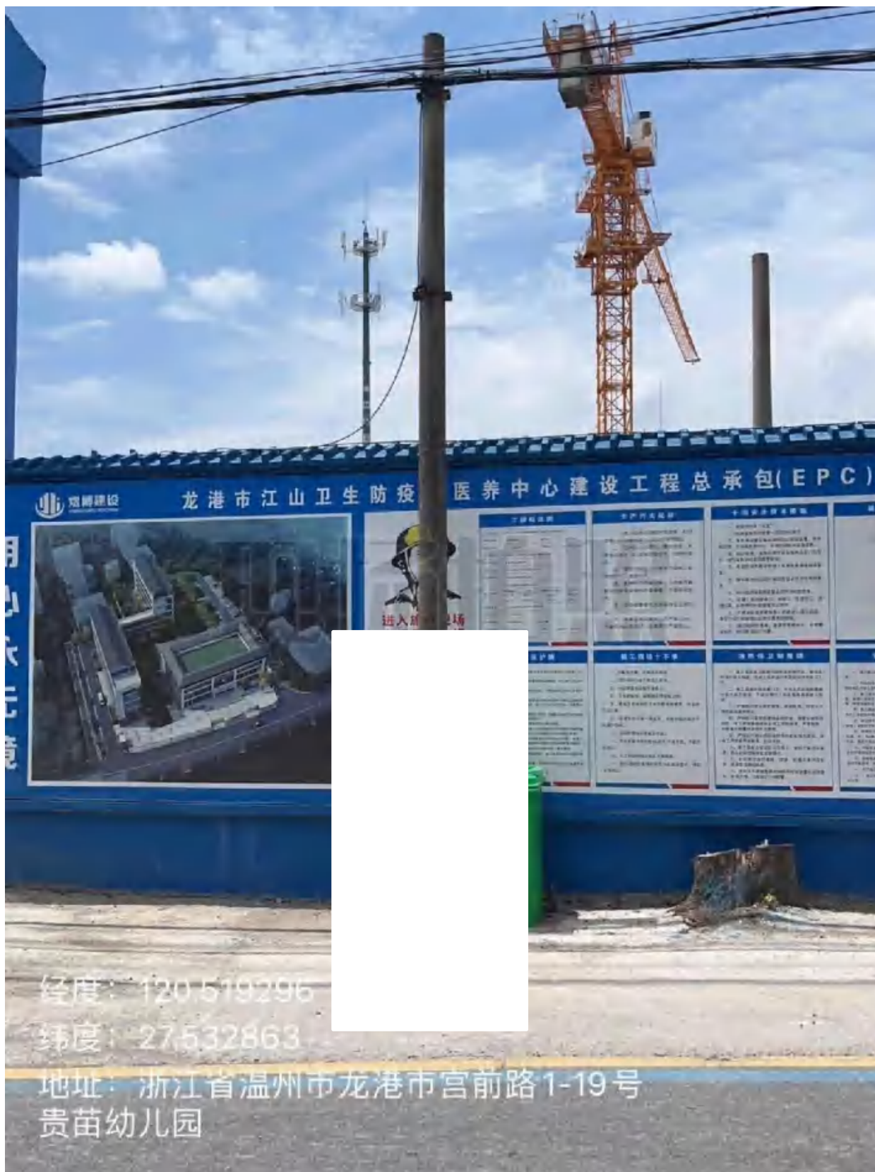
附图 8 工程师现场踏勘照片
