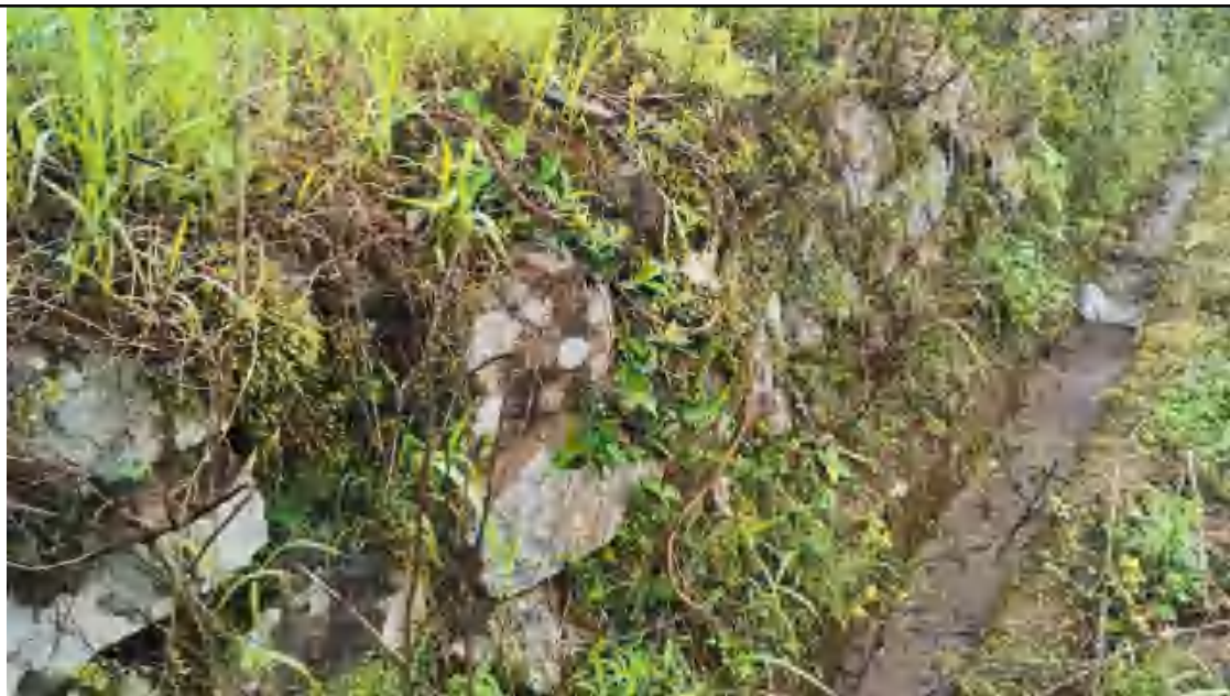
老河堤砌石挡墙
