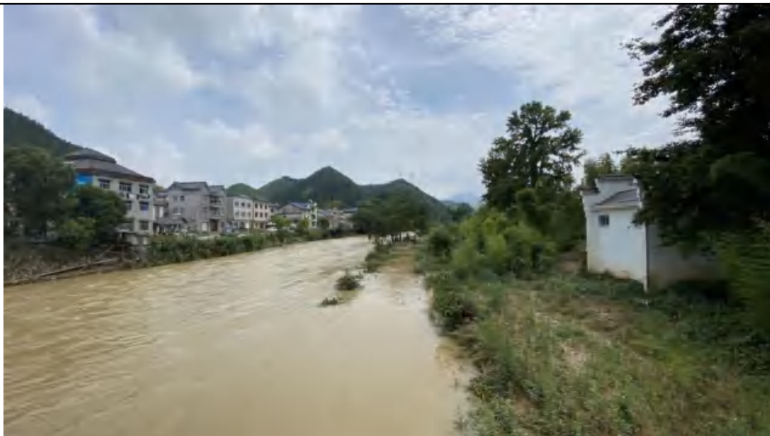
杨村村 2 段洪水冲刷岸坡及房屋
