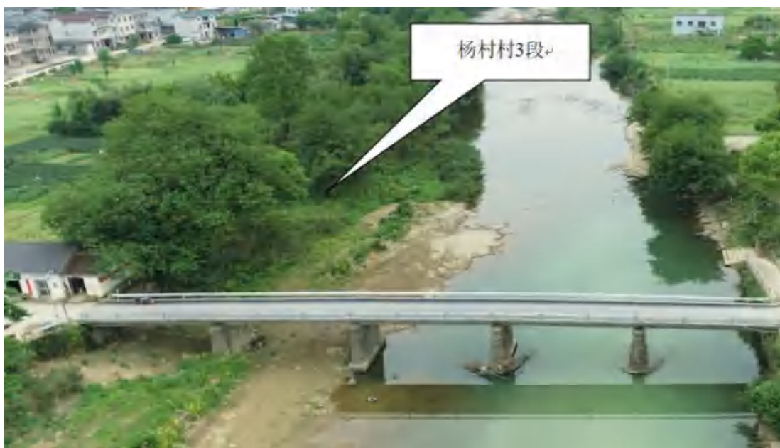
左岸为杨村村 3 段，起点为杨村桥
