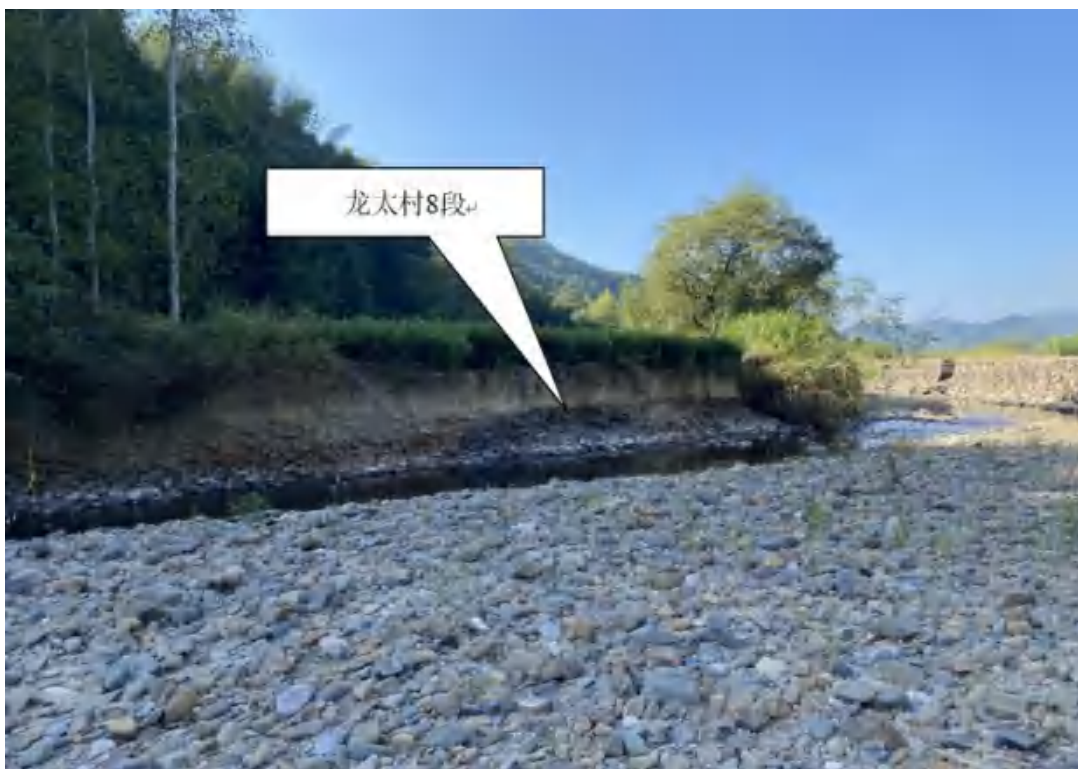
洪水冲刷，造成农田土壤流失
