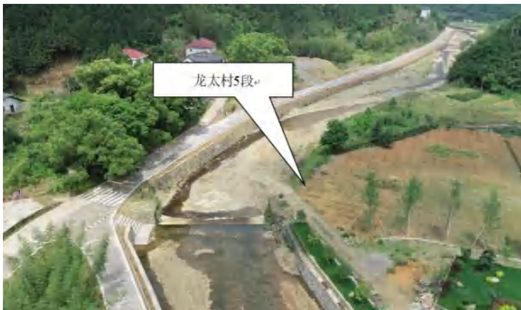
右岸为龙太村 5 段、护岸缺口修复
